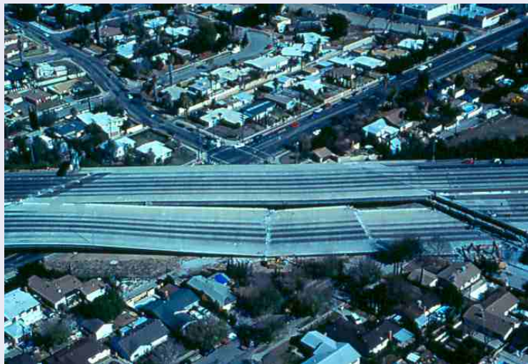
1994 Northridge 地震で崩壊した高速道路
